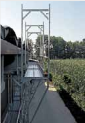
Montaggio di mensola a sbalzo e puntone di rinforzo nel caso di proseguimento ponteggio.
