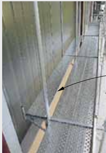
Allargamento del piano di calpestio verso parete con mensola da 0,40.
