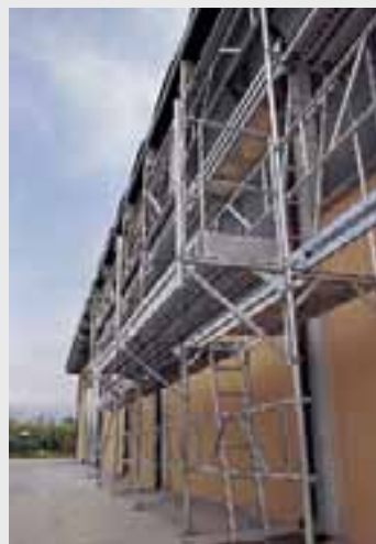
Piano di calpestio realizzato a sbalzo in qualsiasi punto del ponteggio.
