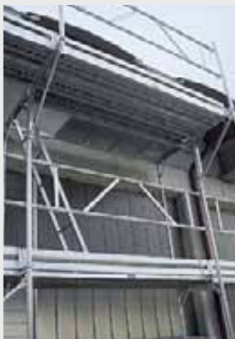
Montaggio della mensola a sbalzo e terminale nel caso di sottotetto.
