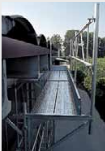
Montaggio della mensola a sbalzo e terminale nel caso di sottotetto.
