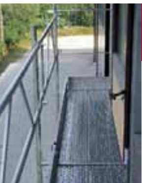
Art. 010/11 Elemento terminale montato in sommità in sostituzione del telaio.
